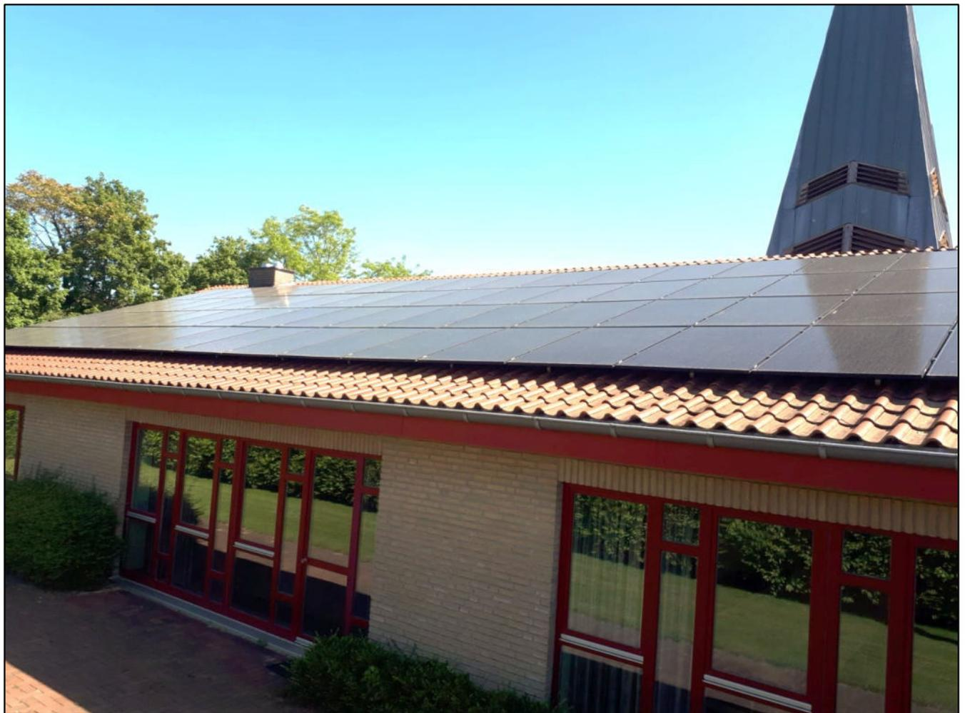
Anlage hat eine Leistung von 28,8 KW und zusätzlich einen Speicher von 12 KW. Der Kirchenvorstand hofft, dass wir mit der Anlage gut aufgestellt sind, um klimaneutral zu werden.
